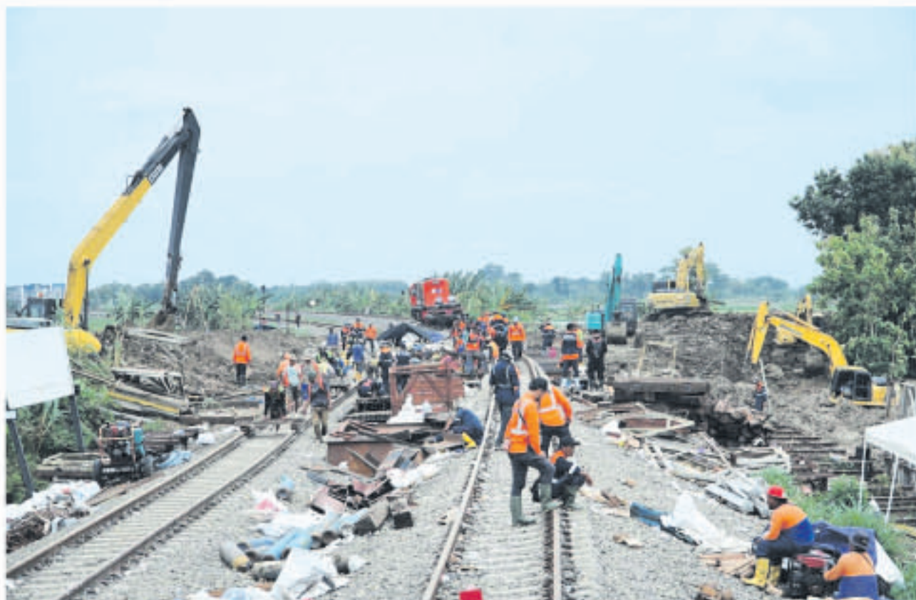
Proses perbaikan rel kereta api di jalur rel di perlintasan KA antara Stasiun Gubug dan Stasiun Karangjati, di Kabupaten Grobogan, Jateng, Minggu (2/2/2025).
