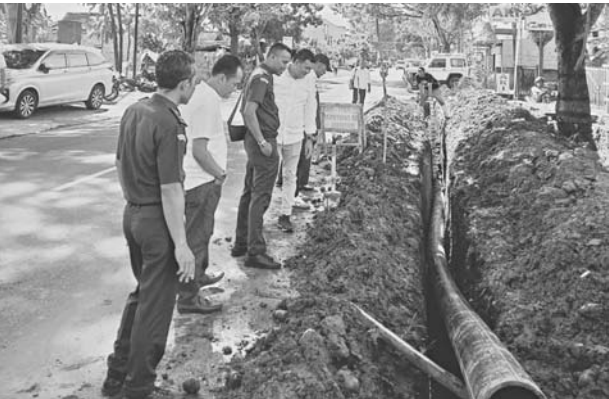
Peninjauan proyek JLS Segmen 2 di Lingkar Selatan Karanganyar.
