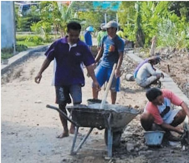
Kegiatan padat karya di Tlajuk Wojo Bangunharjo buat talut dan corblok jalan.
