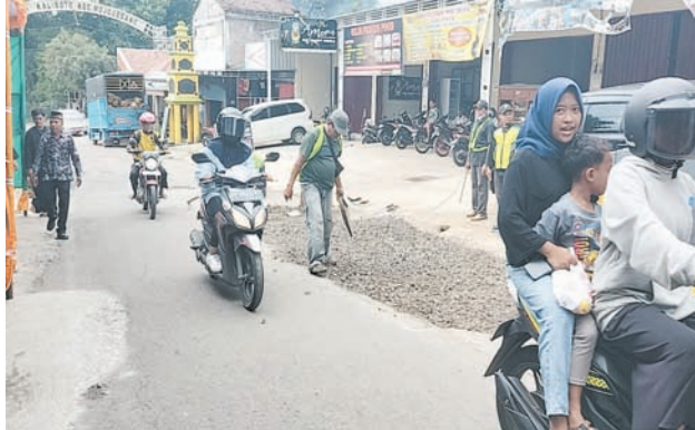
KR-Abdul Alim Perbaikan ruas jalan di Karanganyar.
