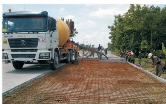
Pengecoran Pelat CAM di proyek peningkatan struktur Jalan Padangan-Bts, Kabupaten Ngawi.
