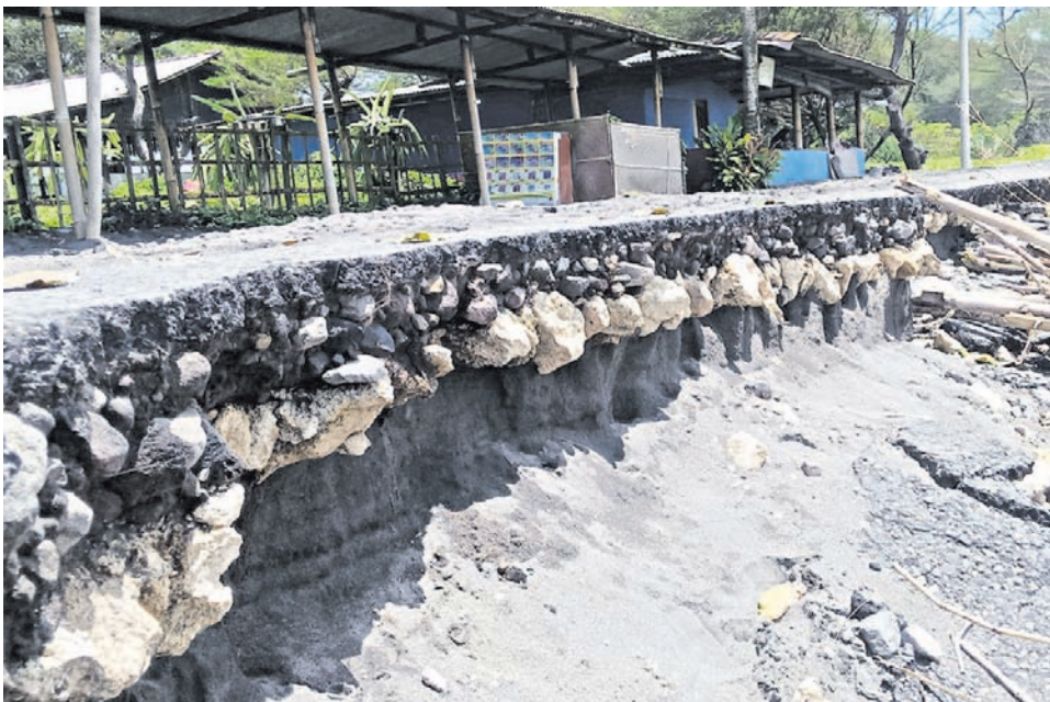
Jalan aspal di kawasan Pantai Pandansari tergerus abrasi, Minggu (8/1).
