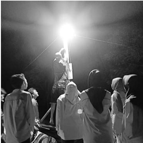
KR-Istimewa Proses pemasangan lampu penerangan jalan Mahasiswa KKN UAD dibantu warga
