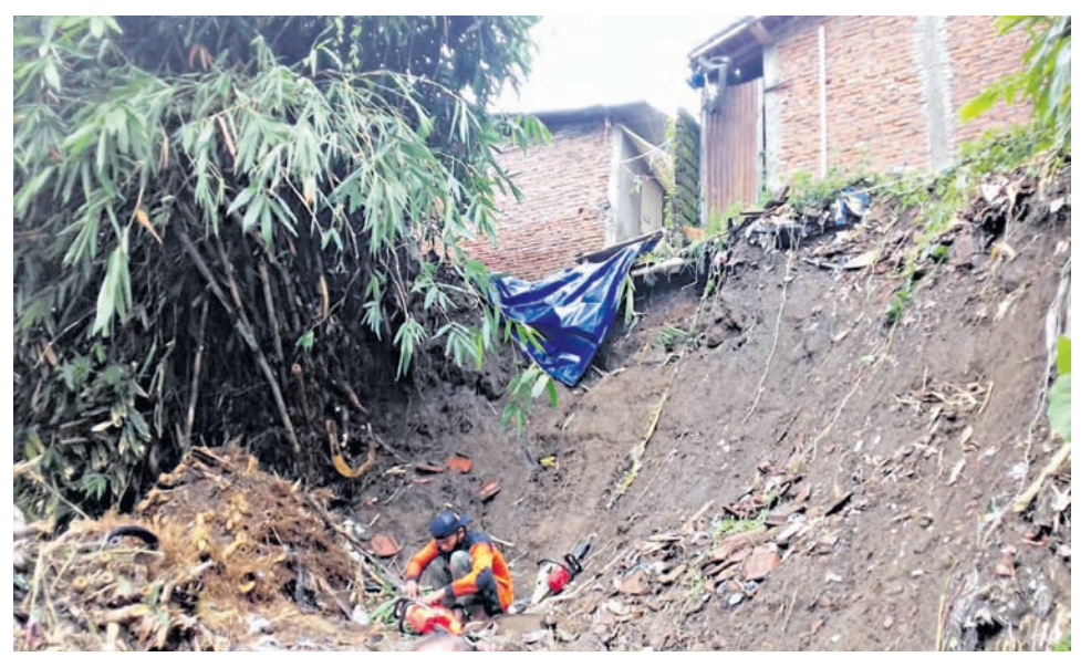
Kondisi tebing di Giwangan yang longsor akibat hujan deras pada Senin (8/2) siang.
