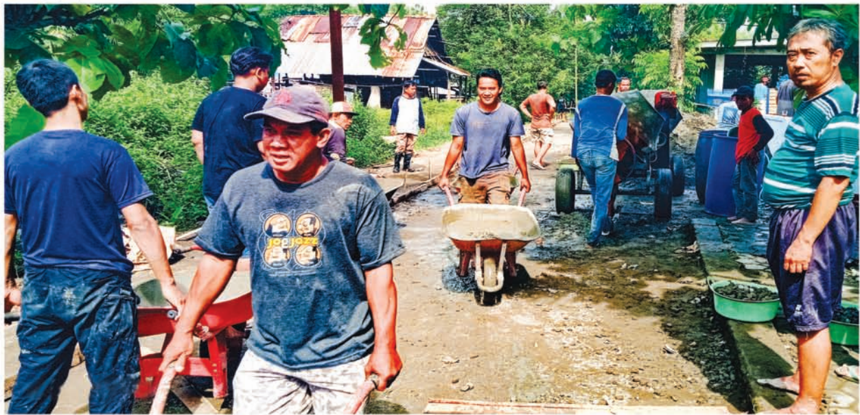
Pengerjaan pembuatan jalan Cor Blog di Kretek Jambitan Banguntapan.
