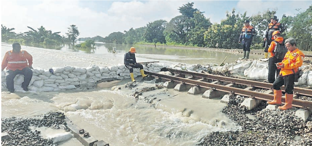
KR-Budiono Untuk sementara, petugas Bersama masyarakat membangun tanggul darurat dengan menggunakan karung yang diisi pasir.
