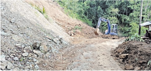
KR-Widiastuti Pengerjaan akses jalan utama yang hampir selesai.
