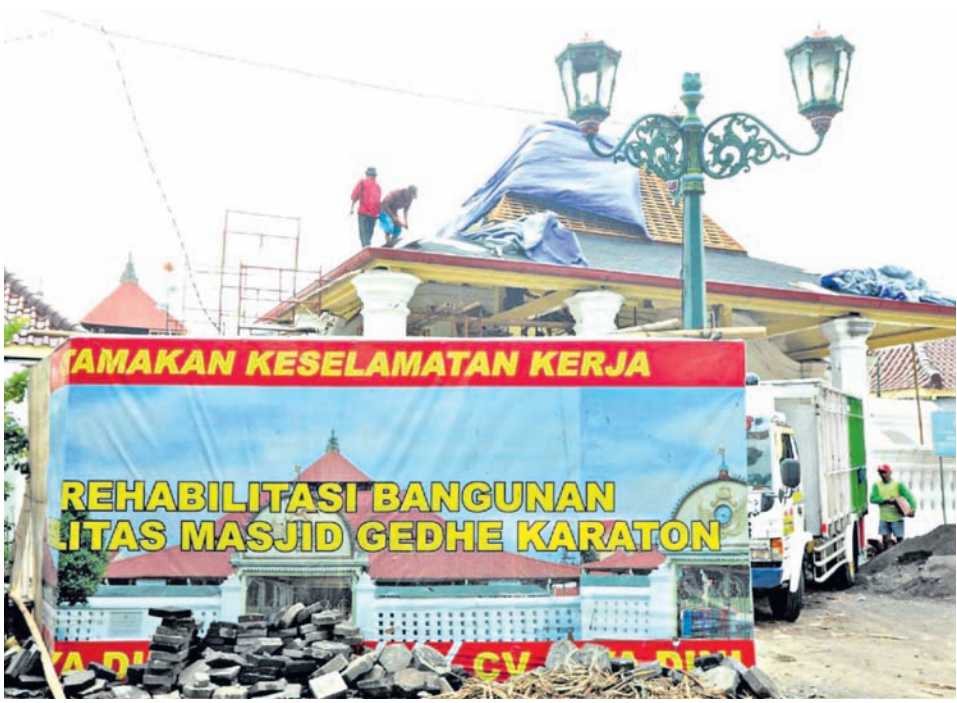
Para pekerja tengah merampungkan rehabilitasi fasilitas Kagungan Dalem Masjid Gedhe Kraton Yogyakarta.
