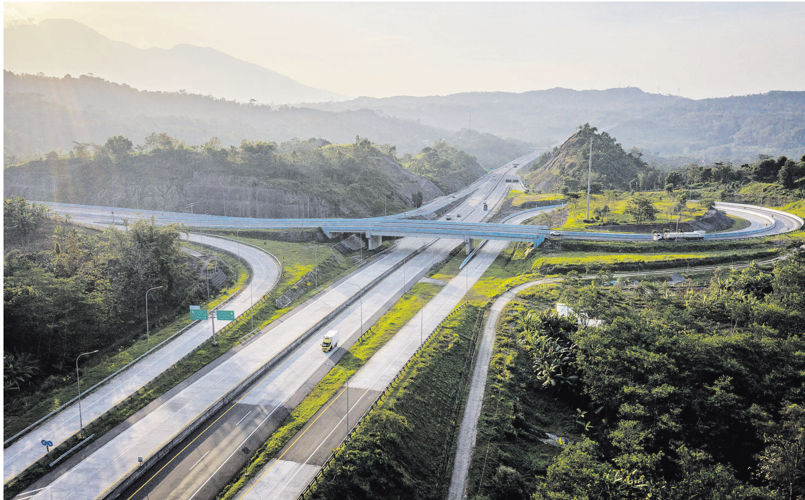
PENUTUPAN PINTU KELUAR TOL: Foto udara suasana mobilitas kendaraan di ruas Jalan Tol Semarang-Solo di Bawen, Kabupaten Semarang, Jawa Tengah, Selasa (13/7). Polda Jateng berencana menutup seluruh pintu keluar tol di Jateng pada Jumat-Kamis (16-22/7) guna membatasi aktivitas maupun mobilitas masyarakat terkait pelaksanaan Pemberlakuan Pembatasan Kegiatan Masyarakat (PPKM) Darurat Jawa-Bali, guna mencegah penyebaran Covid-19. Beritanya di halaman 6.
