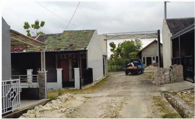
Jalan lingkungan Bhayangkara Residence.
