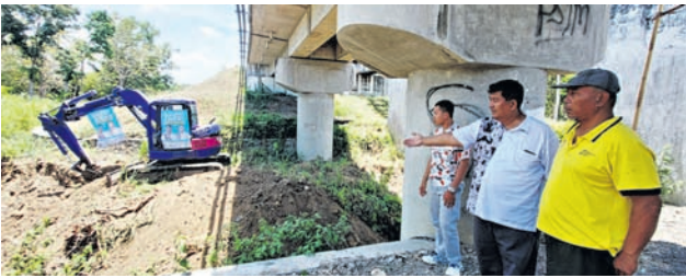
KR-Asrul Sani Alat berat mengeruk sendimen tanah sungai di Pedukuhan Kedungsogo.
