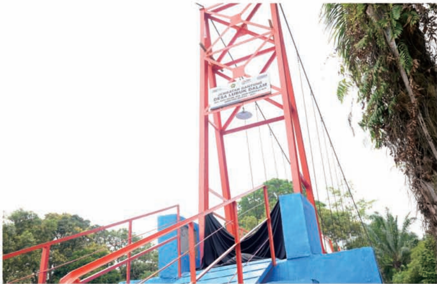
Konstruksi jembatan gantung yang dibangun BRI lewat program BRI Peduli
