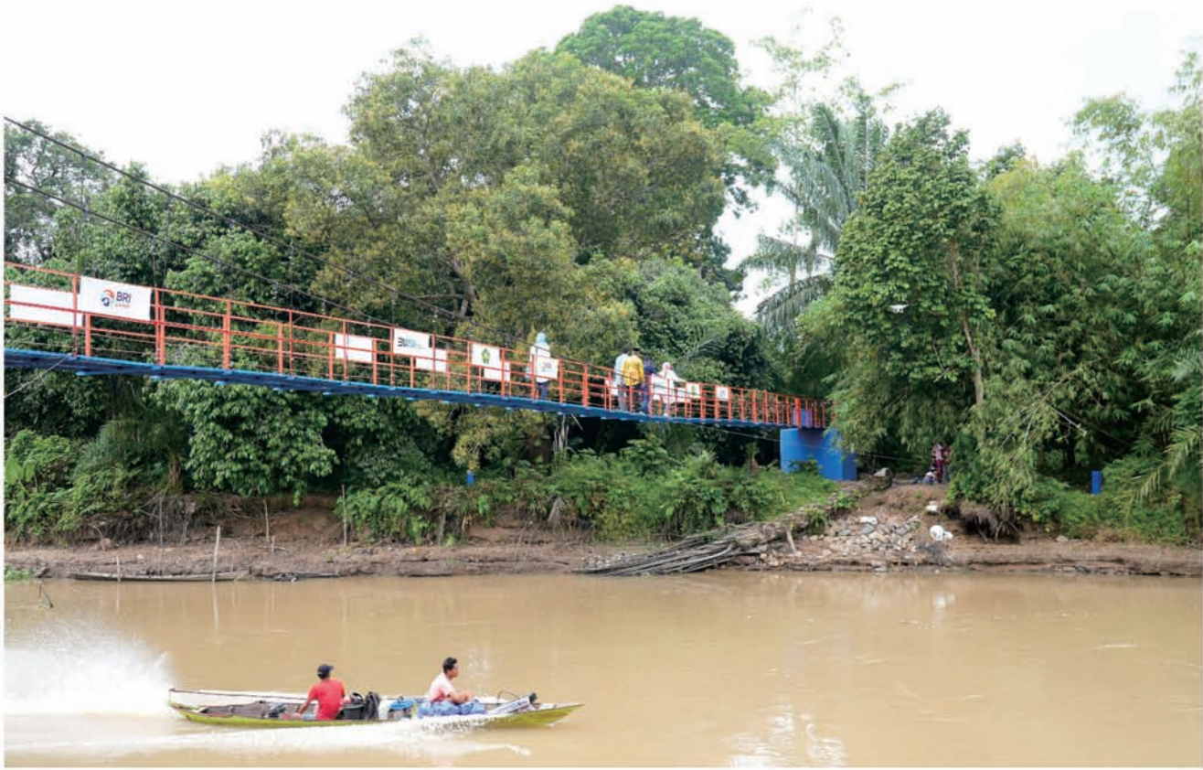
PT. Bank Rakyat Indonesia (Persero) Tbk melalui program BRI Peduli membangun sebuah jembatan gantung di Desa Lubuk Dalam, Kecamatan Kayu Agung, Kabupaten Ogan Komering Ilir, Sumatera Selatan.
