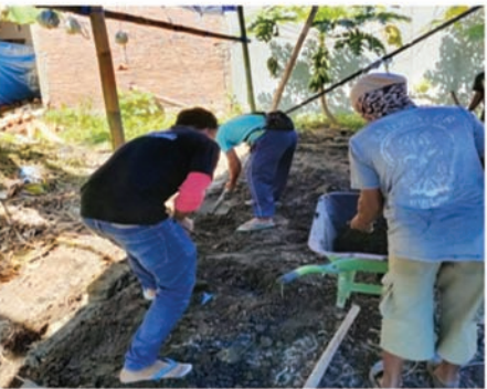
Proses pembangunan gedung TPA Darurat
