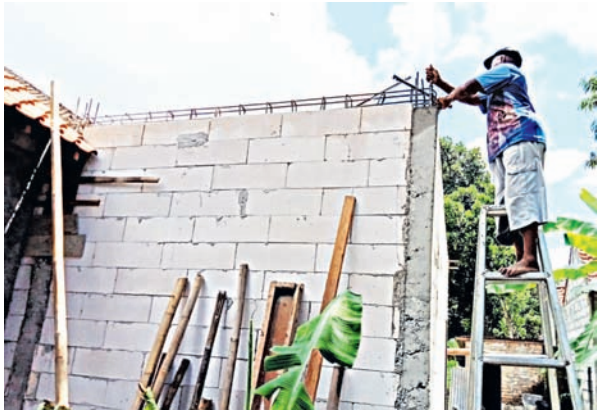
Aktivitas warga dalam proses pembangunan rumah.
