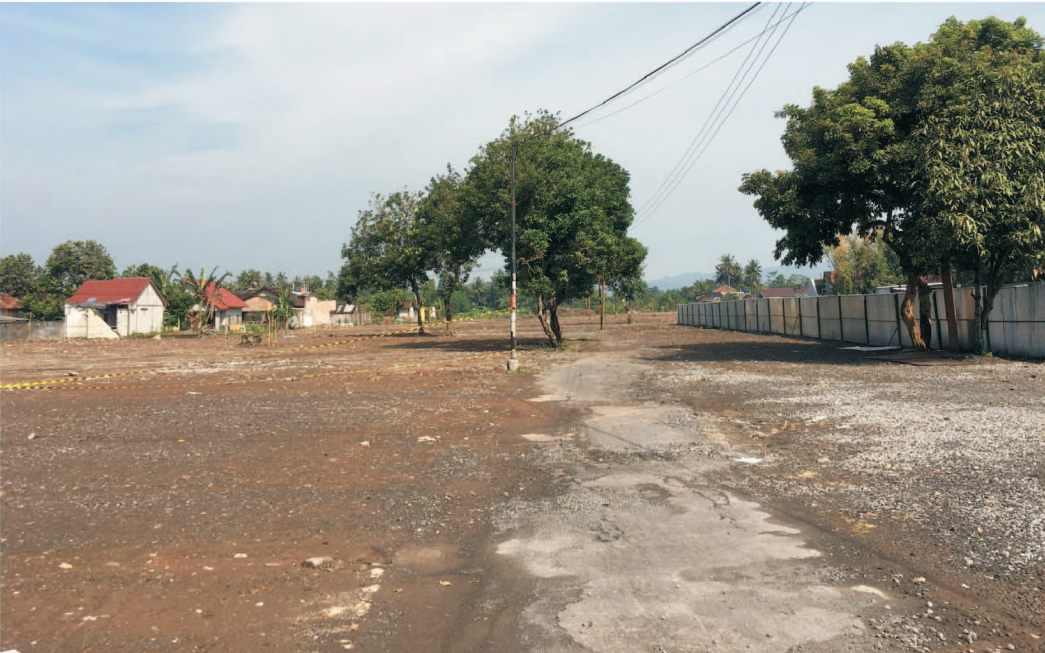
Lahan untuk pembangunan Jalan Tol Yogyakarta-Bawen.
