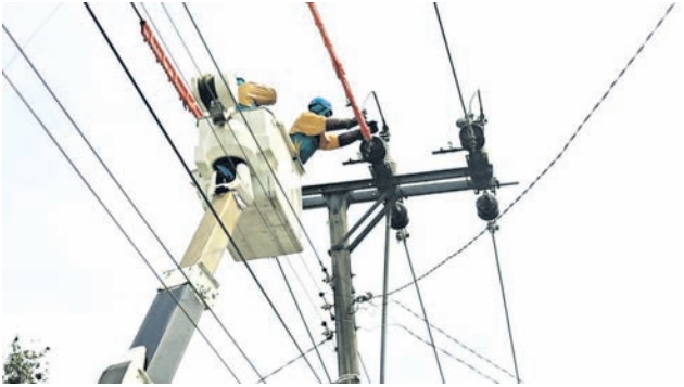
Tim PDKB UP3 Yogyakarta tengah melakukan perbaikan jaringan listrik tanpa padam.
