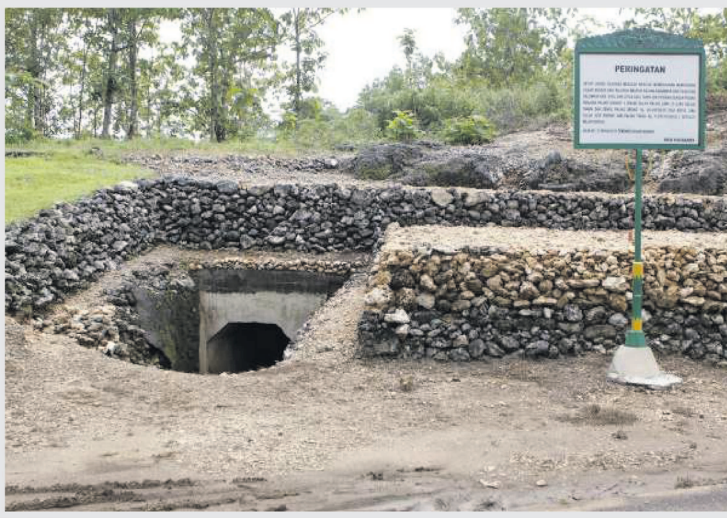
Salah satu bunker Gua Jepang Pundong
