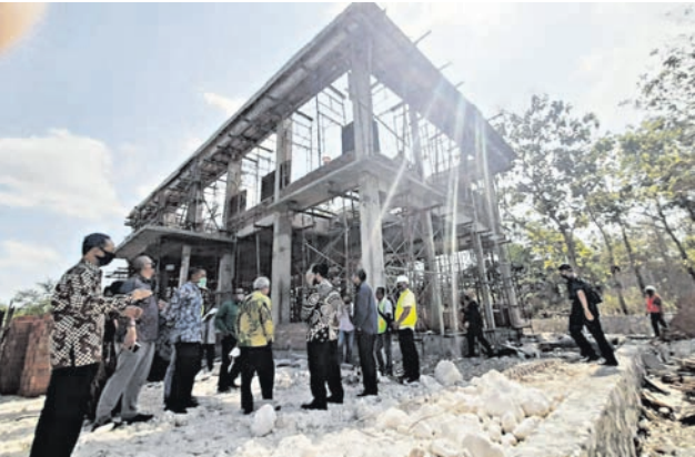
Prof Nizar didampingi jajaran Kanwil Kemenag DIY meninjau pembangunan Gedung PLHUT.
