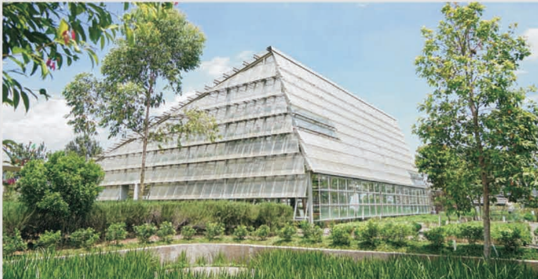
Bangunan greenhouse di Taman Aromatik.
