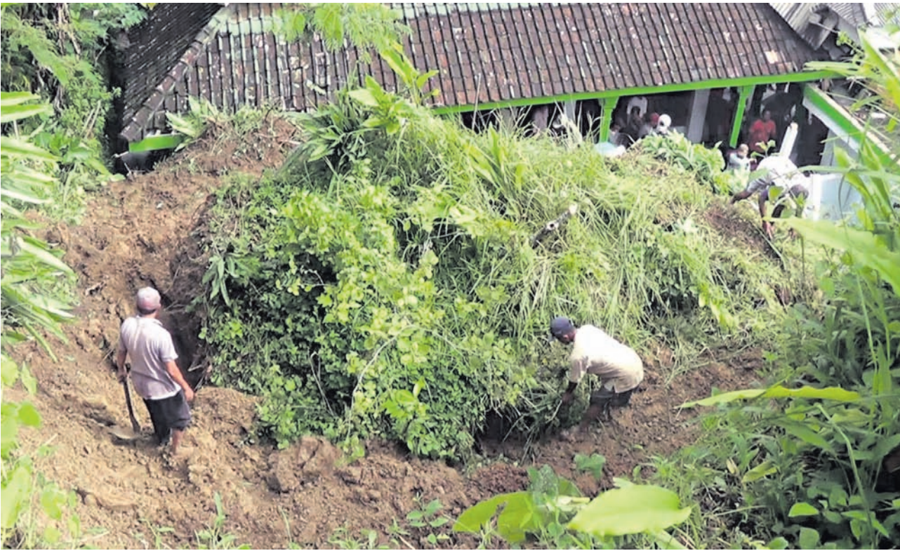
Kerja bakti menyingkirkan material longsor di Kota Magelang, Kamis (27/1).
