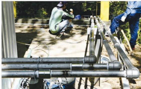
Pemasangan pipa stainless steel 1,25 inci oleh tim peningkatan sistem distribusi air bersih di Goa Ngejring. 3 set pipa stainless steel ini terhubung dari dasar goa dengan 3 pompa submersible (2 pompa Franklin dan 1 pompa Grundfos) ke rumah pompa.
