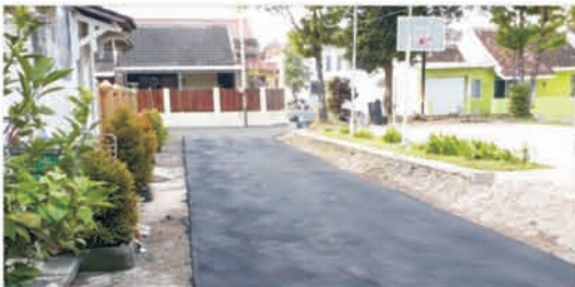
Rehabilitasi jalan kalurahan di Padukuhan Mejing Lor.
