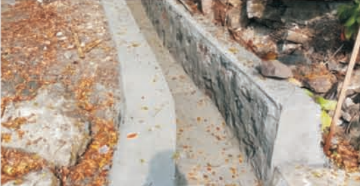
Pembangunan talud di Padukuhan Watulangkah.
