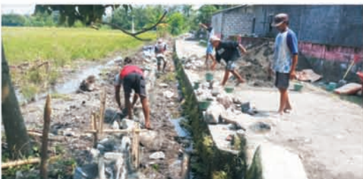
Pembangunan talud untuk saluran drainase Padukuhan Patukan.
