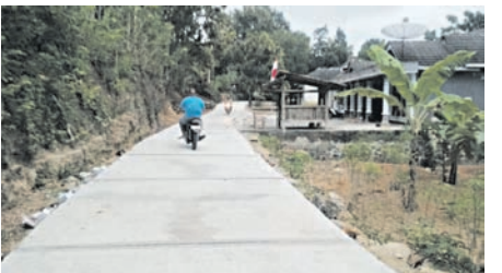
Pemanfaatan jalan hasil PISEW di Mangunan.
