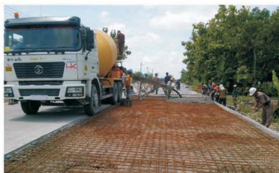
Pengecoran Pelat CAM di proyek peningkatan struktur Jalan Padangan-Bts, Kabupaten Ngawi.
