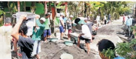
REHABILITASI JALAN PADUKUHAN KALIMANTAN
